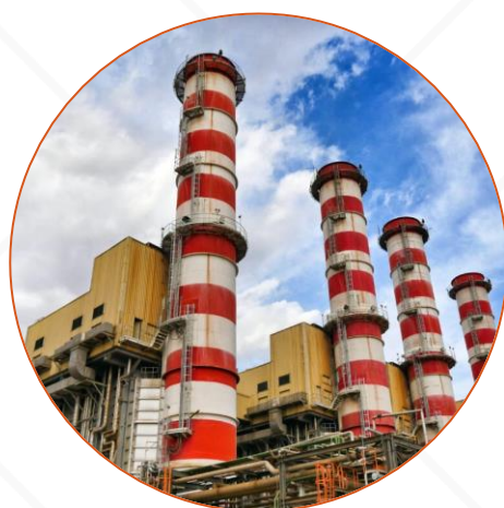
بهره برداری و تعمیرات نیروگاه صبا
