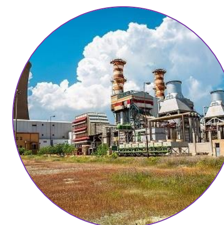
نیروگاه گازی ری
