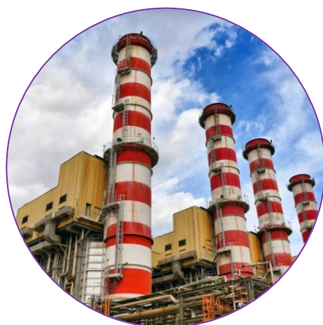
نیروگاه سیکل ترکیبی قم
